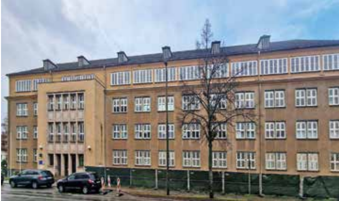
Das Hauptgebäude wird saniert.
