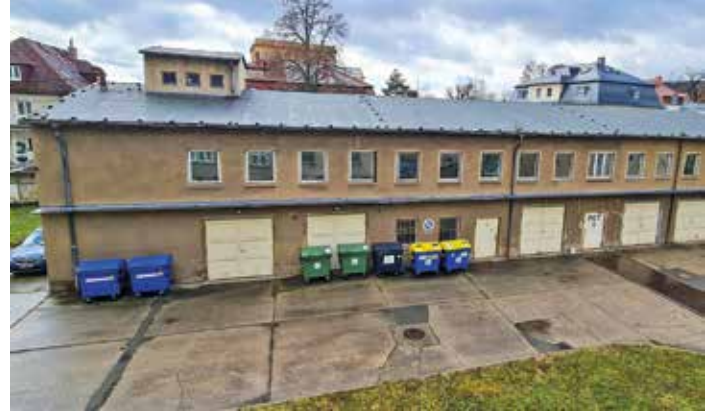
Das Haus 3 wird abgerissen.
